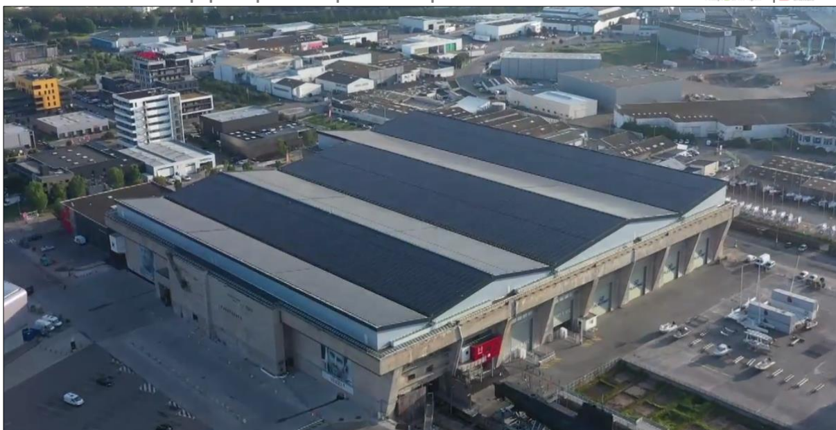
Illustration 9 : Bloc K2 équipé de panneaux photovoltaïques
